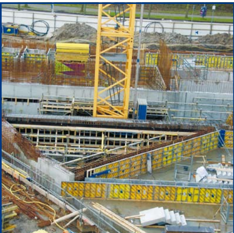
Nog geen hout te zien
